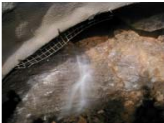
(obr. č.5) podzemní potok v tunelu Euerwang
