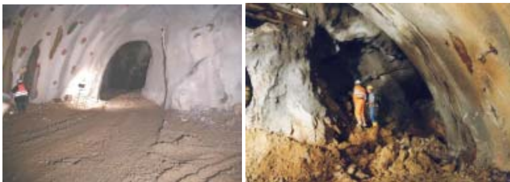
(obr. č. 1,2) jeskyně zastížené během ražby tunelu Irlahüll
