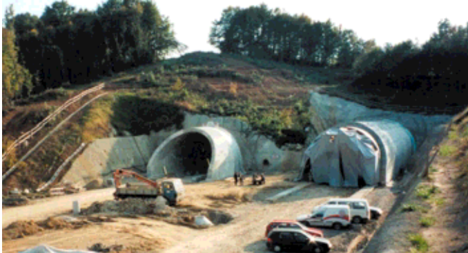
Obr. 1 Pohled na stavební jámu severních portálů a hloubeného úseku Fig. 1 A view of the construction pit for the north portals and the cut-and-cover section
