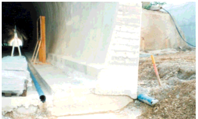
Obr. 10 Pohled na tunelovou drenáž u portálu (vpravo) a odvodnění vrstev vozovky (vlevo) Fig. 10 View of the tunnel drainage at a portal (right), and drainage of the sub-base courses (left)
