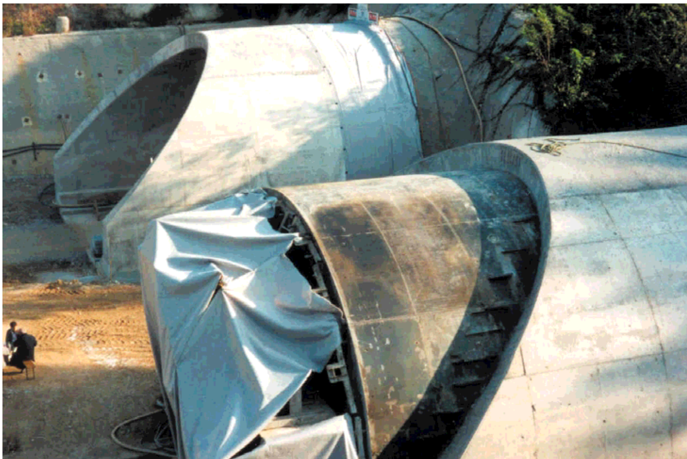
Obr. 7 Pohled na severní portály po dokončení betonáže
