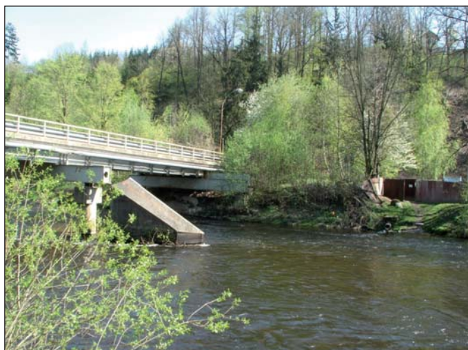
Obr. 5 Provizorní most u severního portálu Fig. 5 Temporary bridge at the northern portal
