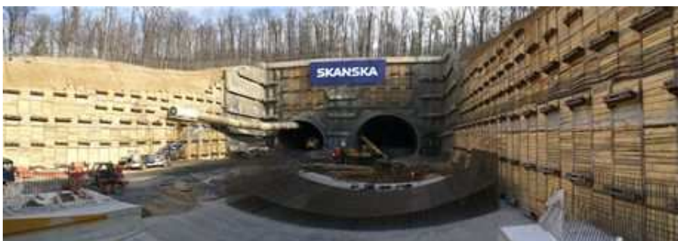
Cholupický tunel - Zajištění stavební jámy Komořany
