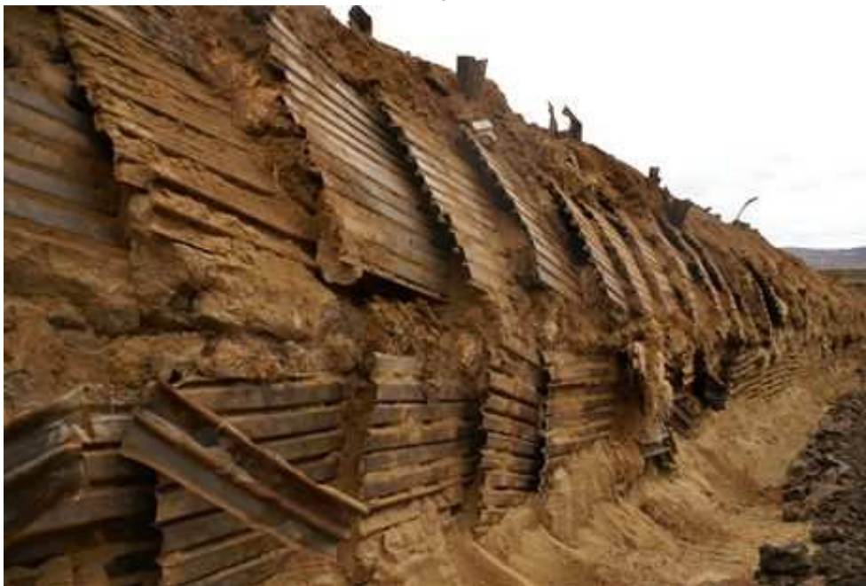
Cholupický tunel - Obnažené ostění průzkumné štolky
