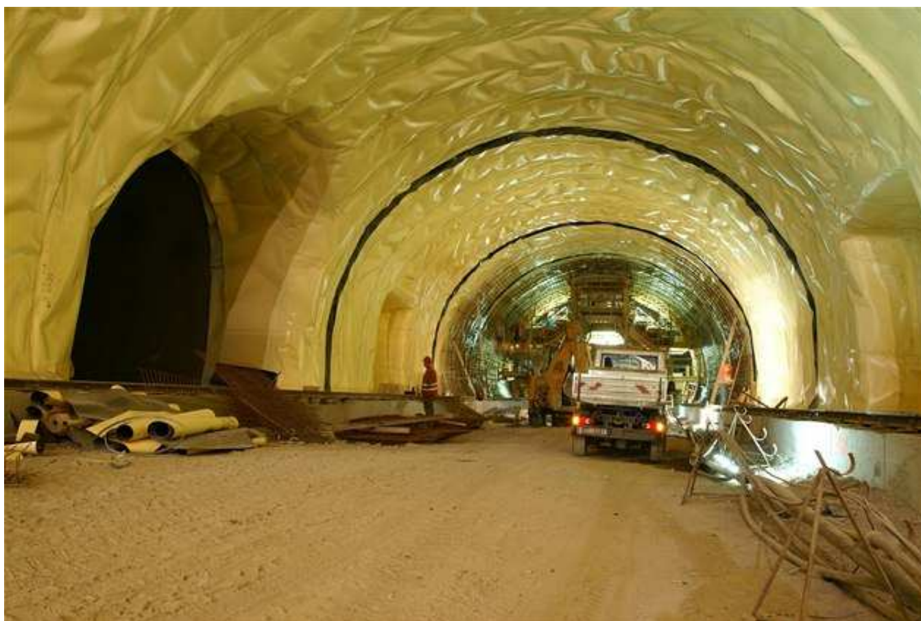
Cholupický tunel - Hydroizolační fólie | foto: Libor Mařík
