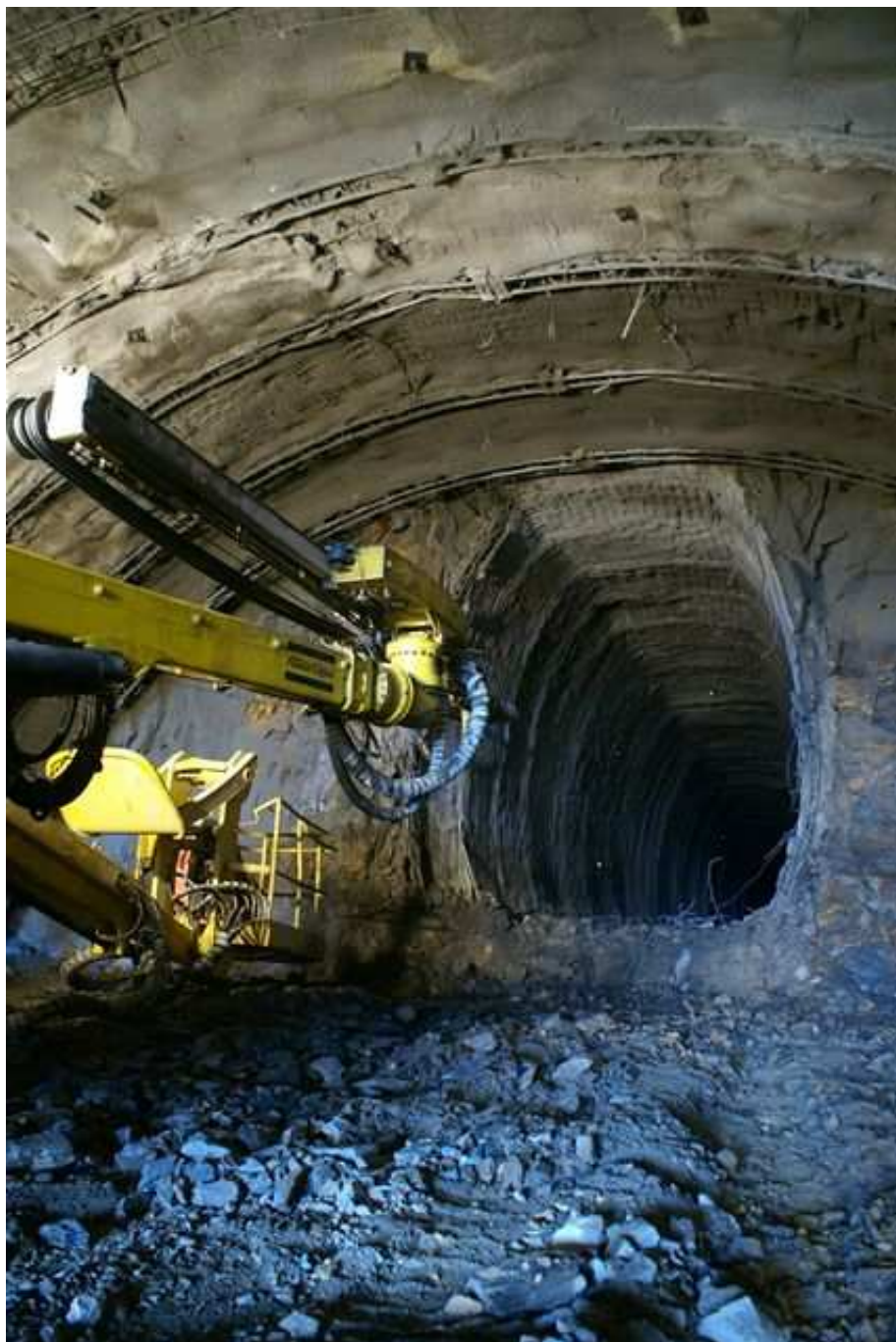
Průzkumná štola v kalotě třípruhového tunelu
