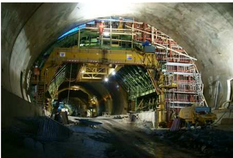
Cholupický tunel - Ocelový most bednicího vozu
