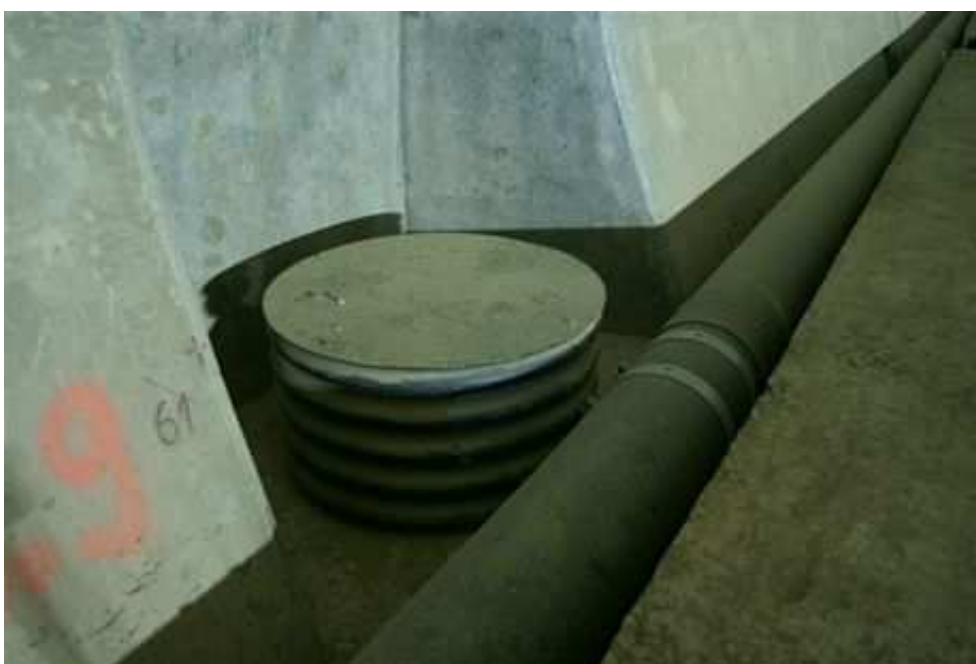
Cholupický tunel - Výklenek se šachtou na čištění drenáže
