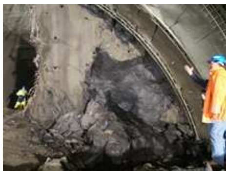
Cholupický tunel - Vypadávání skalních bloků z čelby tunelu
