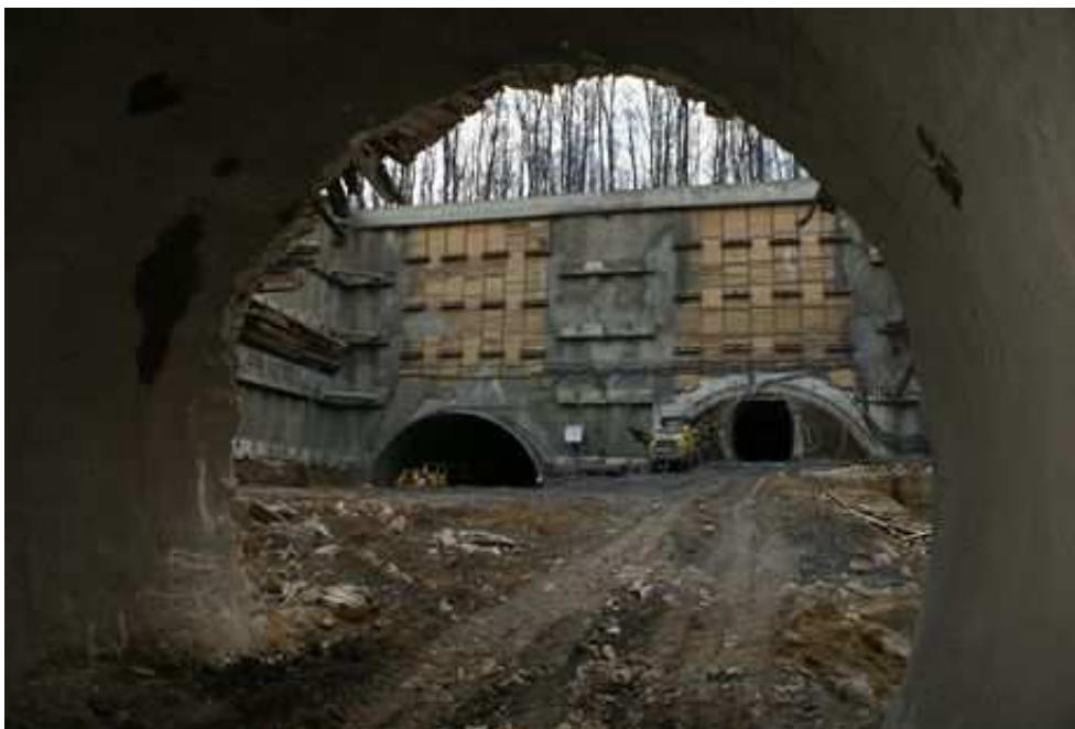
Cholupický tunel - Pohled z ubourané průzkumné štolky na portálovou stěnu
