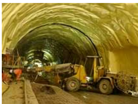
Cholupický tunel - Hydroizolační fólie
