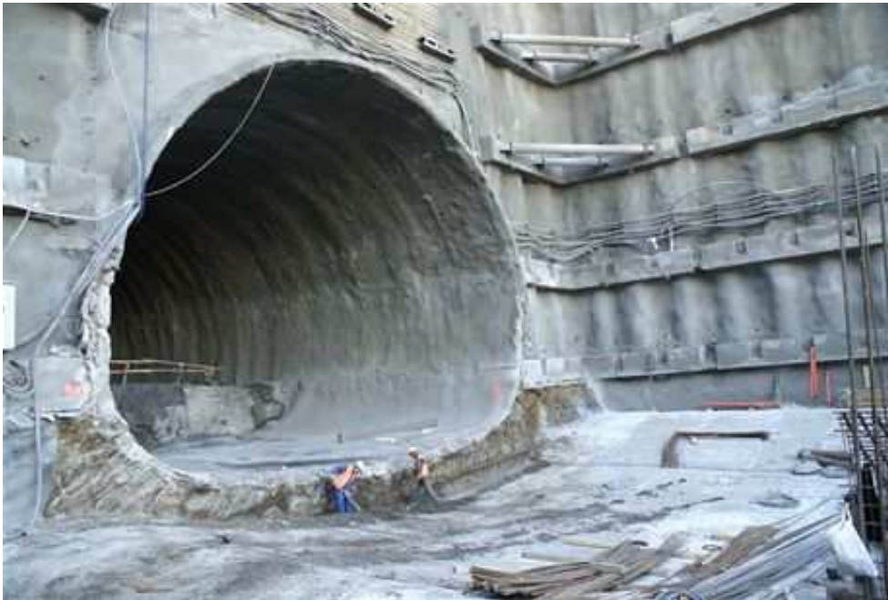
Cholupický tunel - Největší profil raženého tunelu
