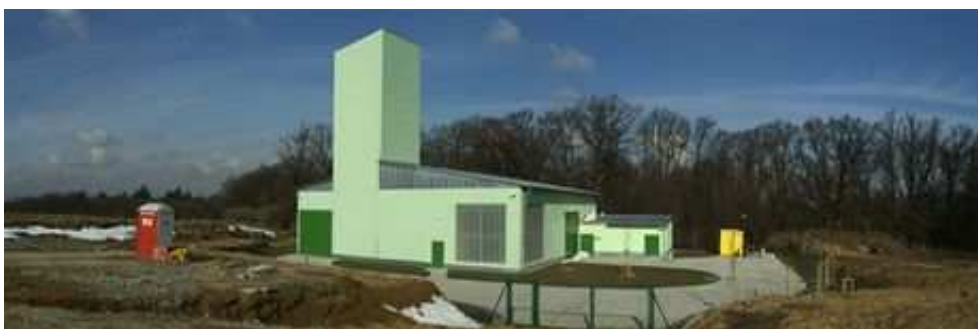
Cholupický tunel - Vzduchotechnický objekt Nouzov
