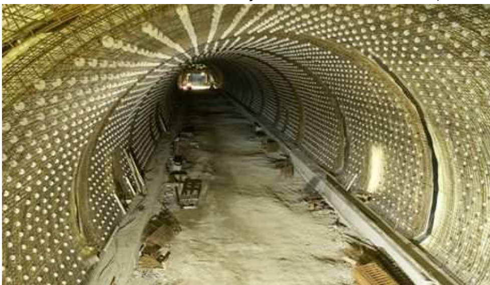
Cholupický tunel - Samonosná výztuž definitivního ostění
