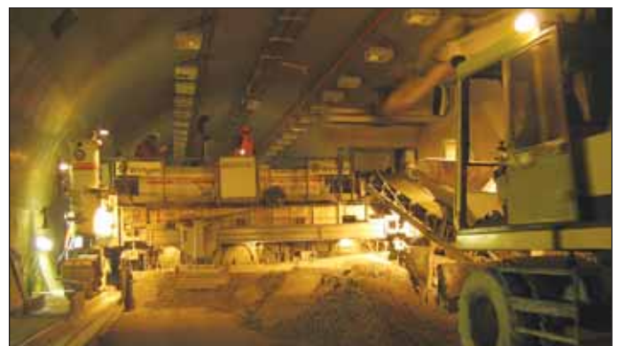
Obr. 5 Stísněné poměry při betonáži vozovky Fig. 5 Constrained conditions during the roadway casting
