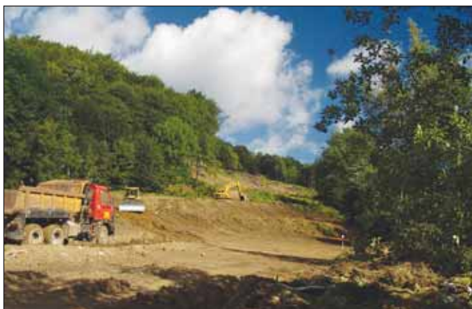
Obr. 1 Jižní portál, příprava území – 8/2004 Fig. 1 Southern portal, site preparation – 08/2004
