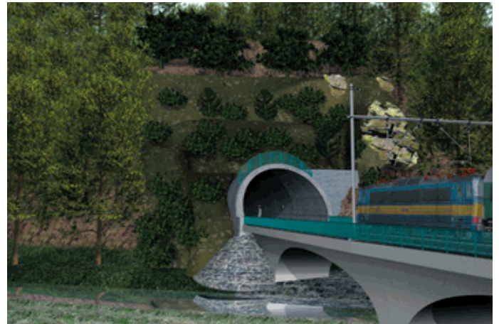
Obr. 8 Vjezdový portál tunelu Malá Huba – napojení tunelu na most přes Moravskou Sázavu Fig. 8 The entrance portal of the Malá Huba tunnel – the connection of the tunnel to the bridge over the Moravská Sázava River
