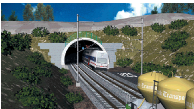
Obr. 7 Výjezdový portál tunelu Hněvkovský I. – zpevnění portálového svahu gabionovou zdí Fig. 7 The exit portal of the Hněvkov I tunnel – the portal slope supported by a gabion wall
