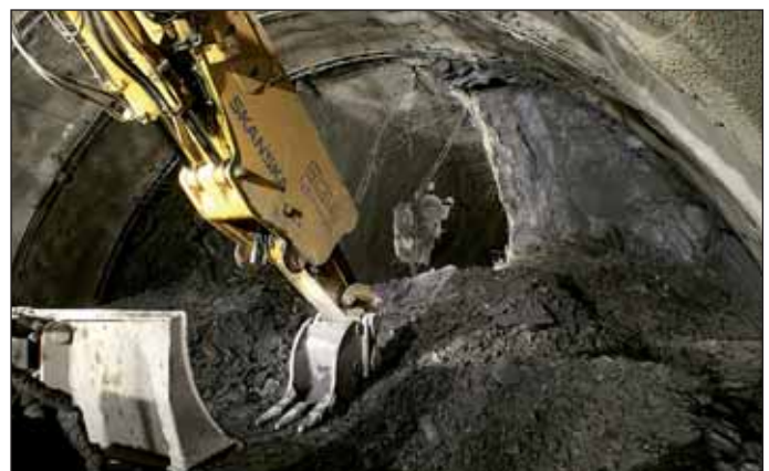
Obr. 3 Geologické poměry na čelbě jižního tunelu Fig. 3 Geological conditions at the excavation face in the southern tunnel
