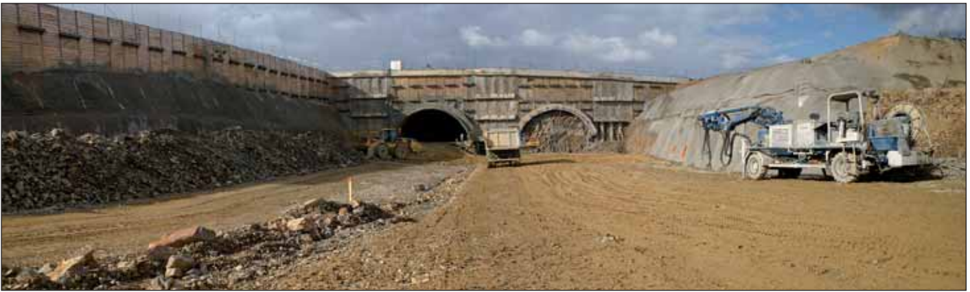
Obr. 2 Pohled na Cholupický portál a stavební jámu Fig. 2 A view of the Cholupice portal and the construction trench
