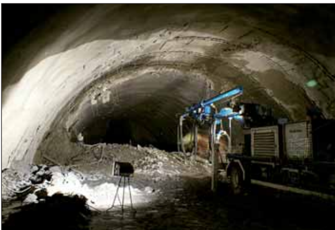
Obr. 8 Bourání ostění průzkumné štoly v přístropí kaloty Fig. 8 Demolition of the exploration gallery lining in the top heading crown
