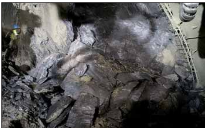
Obr. 4 Nestabilita čelby při nepříznivém sklonu vrstev
