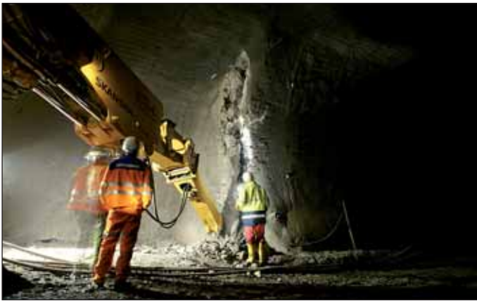
Obr. 7 První úder bouracího kladiva při zahájení ražby ze štoly Fig. 7 Initial blows by the impact hammer on the commencement of the excavation from the gallery
