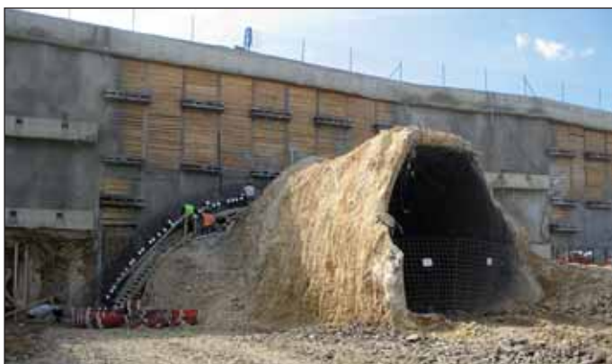
Obr. 6 Bourání ostění průzkumné štoly v oblasti jámy Cholupice
