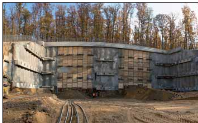
Obr. 5 Pažení stavební jámy Komořany
