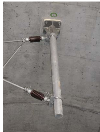
Obr. 6.6 – Upevnění závěsu trakčního vedení.
