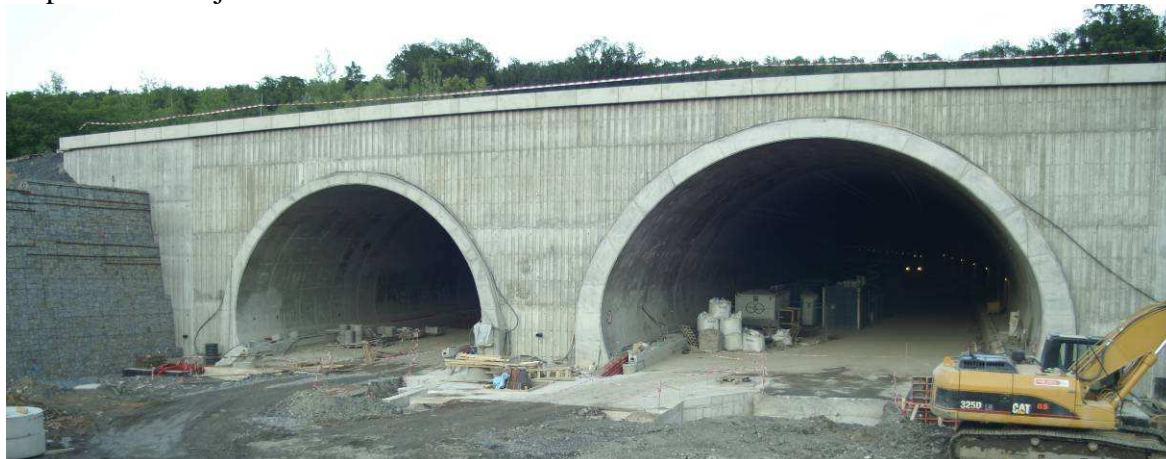
Obr. 3 Hloubené tunely na portále Komořany
