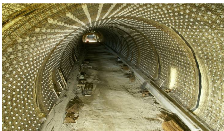
Obr. 1 Samonosná výztuž raženého úseku tunelu
