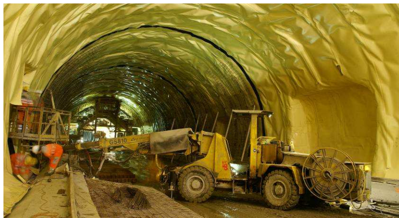
Obr. 4 Ražený úsek tunelu s hydroizolační fólií
