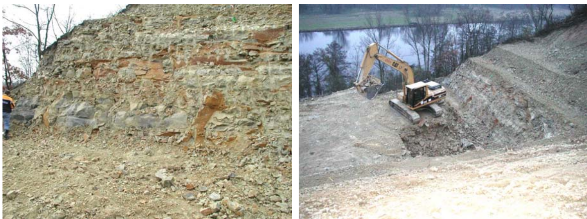
Obr. 3 Geologické poměry portálového svahu potvrdily předpoklady IG průzkumu
