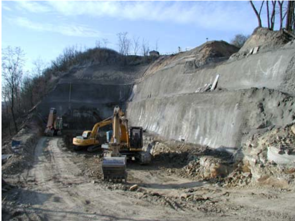
Obr. 4 Stavební jáma děčínského portálu
