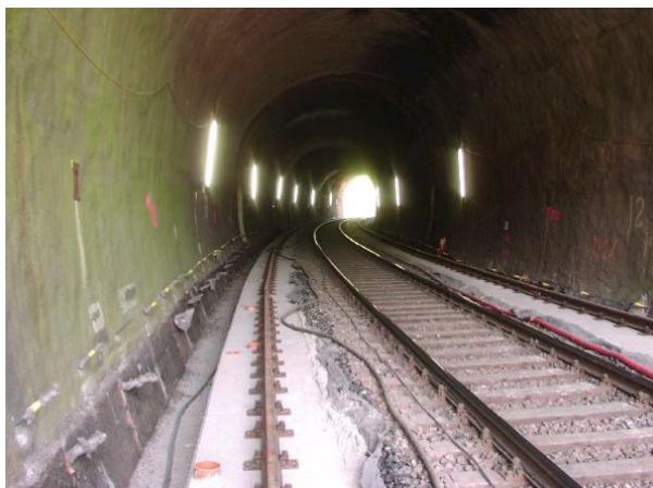
Obr. 1 Základ a kolejnice pro pojezd razícího tunelového portálu a bednicího vozu
