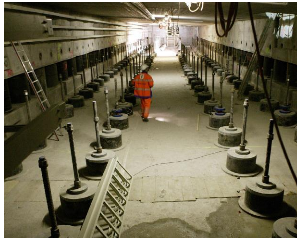
Obr. 16 Kotvení počvy tunelu
