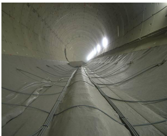
Obr. 7 Vedení potrubí v počvě tunelu
