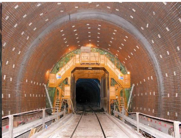
Obr. 6 Výztuž definitivního ostění
