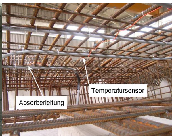
Obr. 8 Výztuž s vedením potrubí v tybinku
