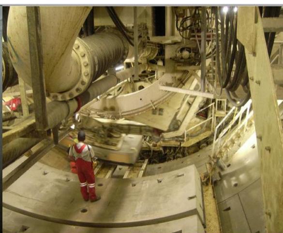
Obr. 10 Montáž tybinků v tunelu Jenbach
