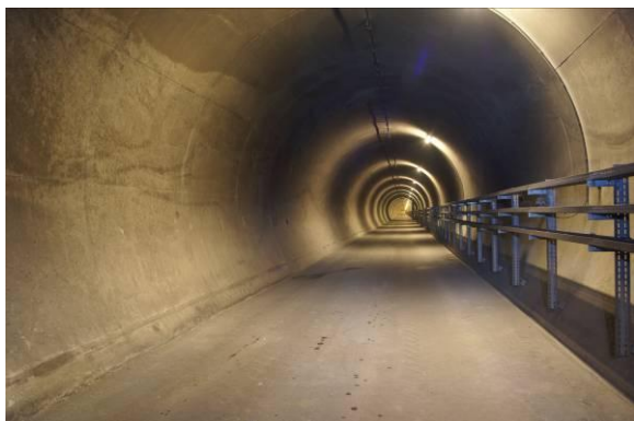
Obr. 13 Monolitické ostění vzduchotechnické štoly
