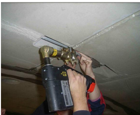
Obr. 9 Spojování potrubí mezi tybinky
