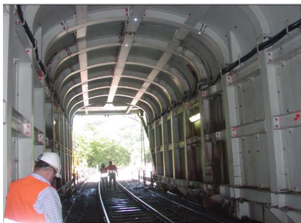
Obr. 2 Průjezdny prostor pod razícím tunelovým portálem
