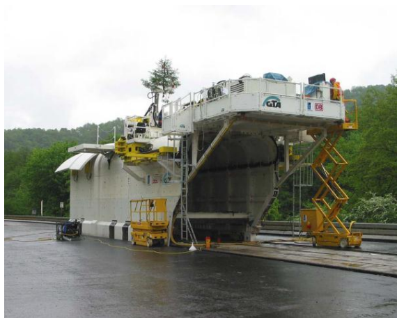
Obr. 3 Smontovaný razící portál
