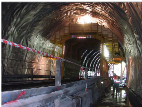
Obr. 5 Montážní vůz v tunelu
