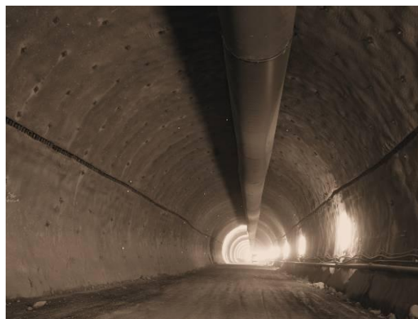
Obr. 12 Deformační elementy v ostění
