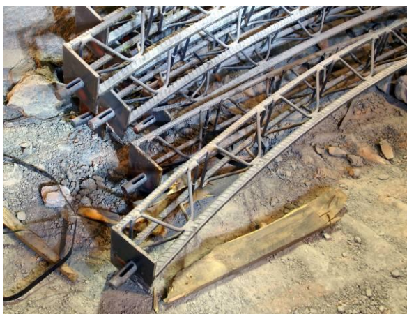
Obr. 11 Čep pro stykování rámu výztuže
