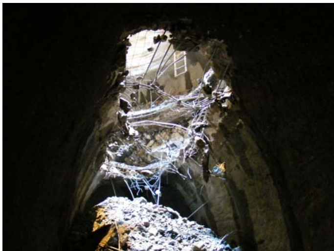
Obrázek 7. Prorážka šachty do přístupové štoly
