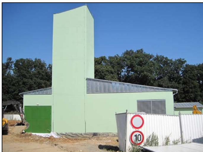
Obrázek 11. Nadzemní část vzduchotechnického objektu
