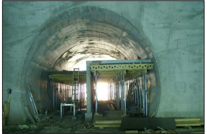
Obrázek 6. Betonáž mezistropu v propojce č. 5
