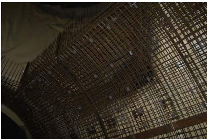
Obrázek 9. Vyztužení prutovou výztuží v místě průniku šachty a propojky č. 5.
