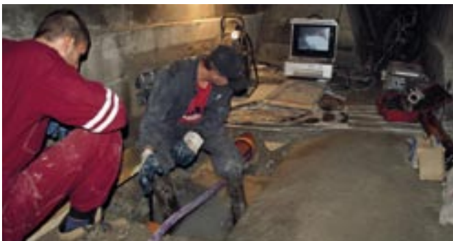
Obr. 11 Čištění zabetonovaných drenáží
