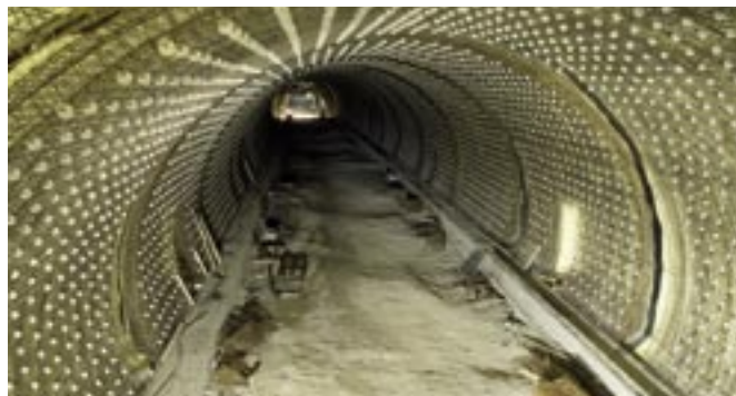
Obr. 8 Samonosná výztuž s distančníky
