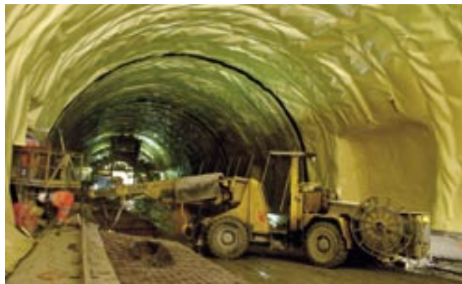
Obr. 4 PE hydroizolace se signální vrstvou
