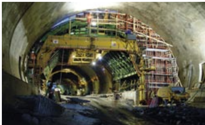
Obr. 3 Nástavec bednicího vozu v místě nouzového zálivu
