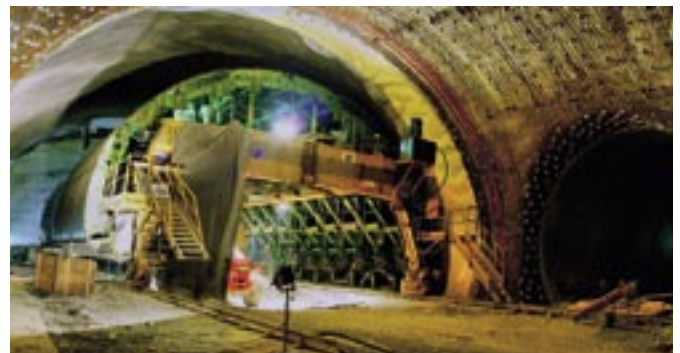
Obr. 12 Výztuž a bednicí vůz v nouzovém zálivu
