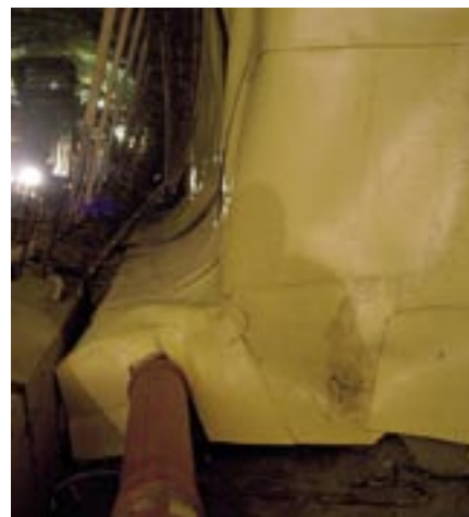
Obr. 5 Ukončení hydroizolační fólie
