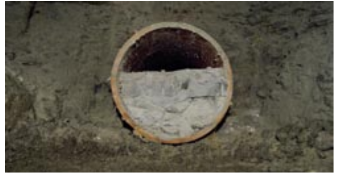
Obr. 10 Drenáž zaplněná injektážní směsí
