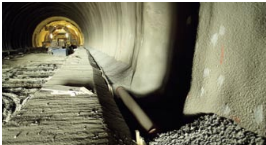
Obr. 6 Potrubí boční tunelové drenáže
