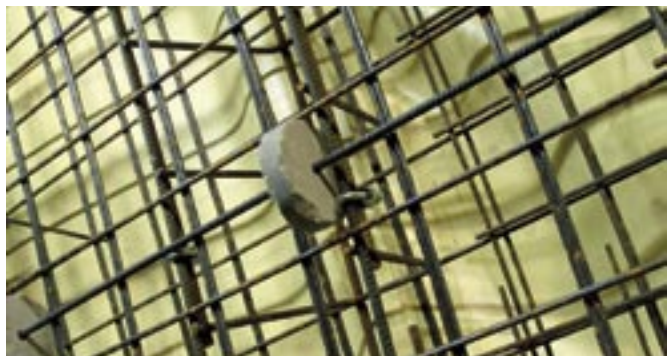
Obr. 7 Stykování nosných rámmů lanovými spojkami
