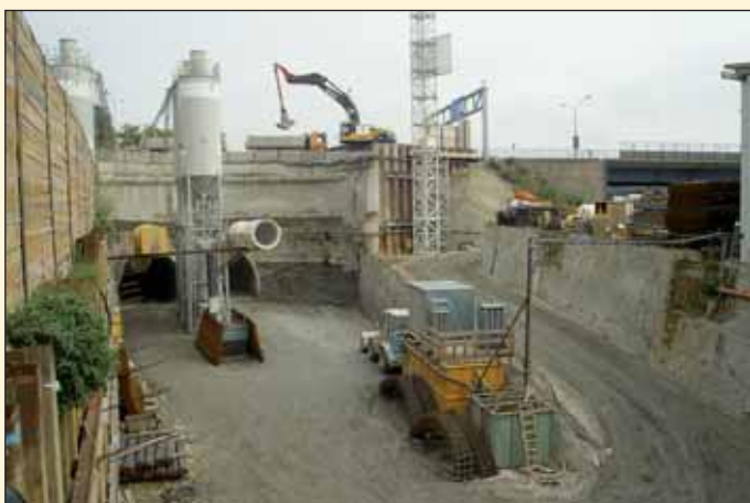
Obr. 6 Stísněné poměry zařízení staveniště Fig. 6 Constricted site area
