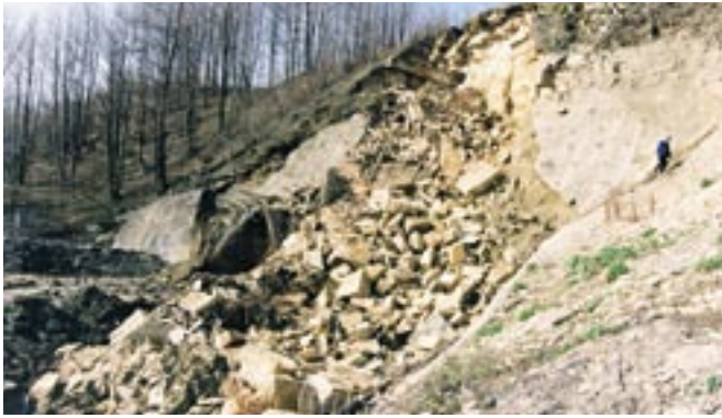
Sesuv východního portálu tunelu Hřebeč
