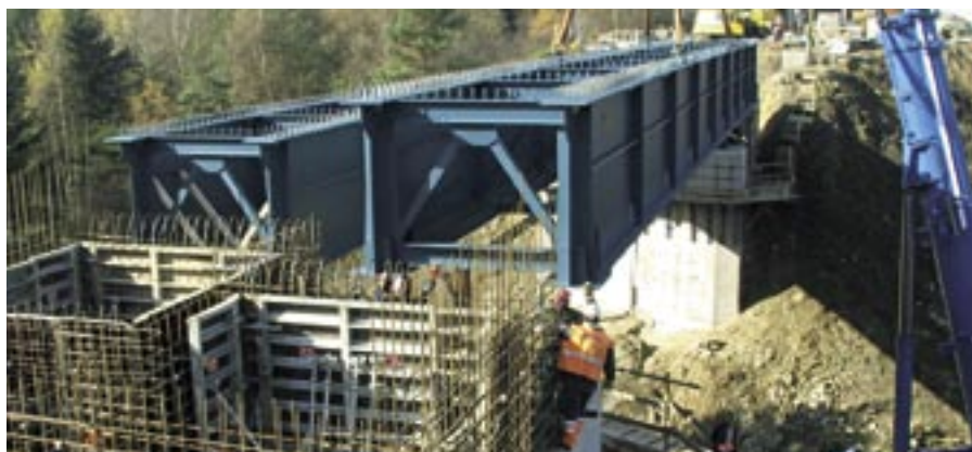
Osazení mostovky železničního mostu na trati Stříbro–Planá
