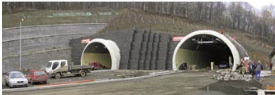
Jižní portál tunelu Libouchec před dokončením
