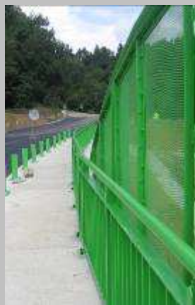
■ Zábradlí a protidotyková stěna
