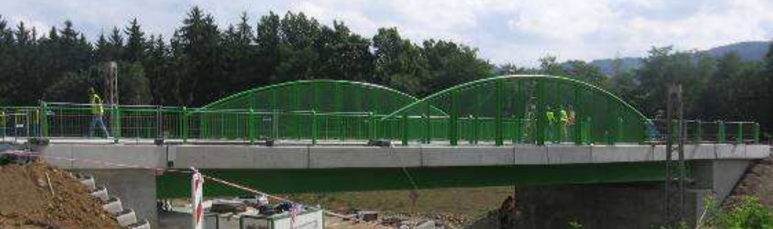
■ Silniční most v st. km 115,760 u obce Votice
