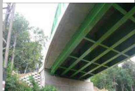
■ Sprážená ocelobetonová nosná konstrukce
