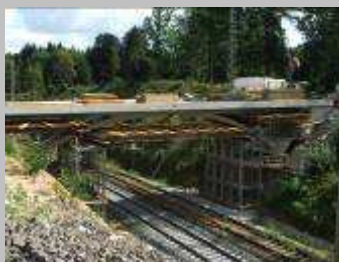
Realizace objektu -Odskruzení konstrukce
