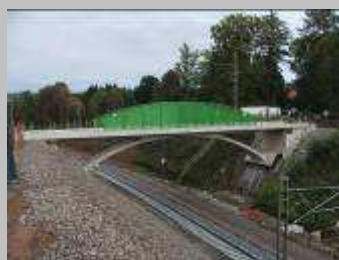
Realizace objektu – Dokončovací práce
