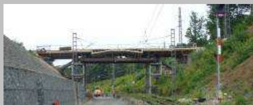
Realizace objektu – systémová skruž nosné konstrukce
