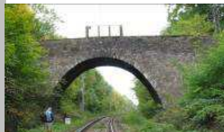
Původní mostní konstrukce
