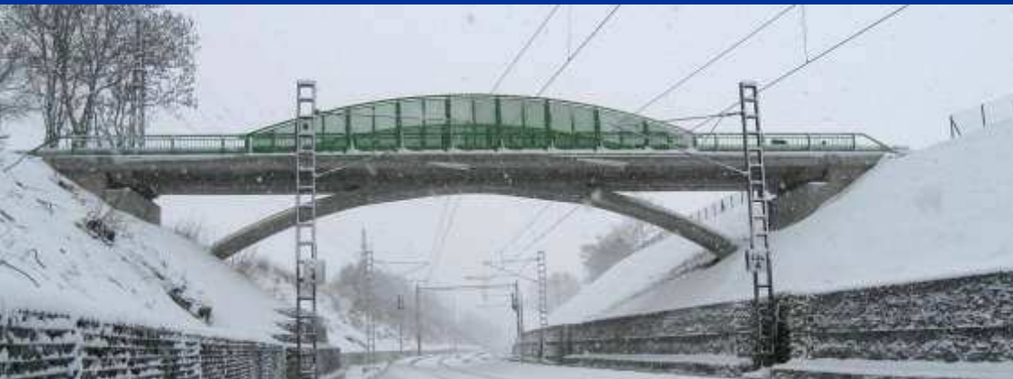
Pohled na dokončenou konstrukci nadjezdu
