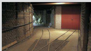
Nové větrní dveře na překopu a odbočení ke směrné chodbě Čelina - západ. Air door on main adit, turning to Deposit Čelina West.
