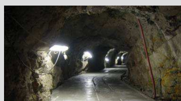
Podlaha po betonáži, vpravo organizovaný svod přítoků z vrtn. After concreting, water downcomer on the right.
