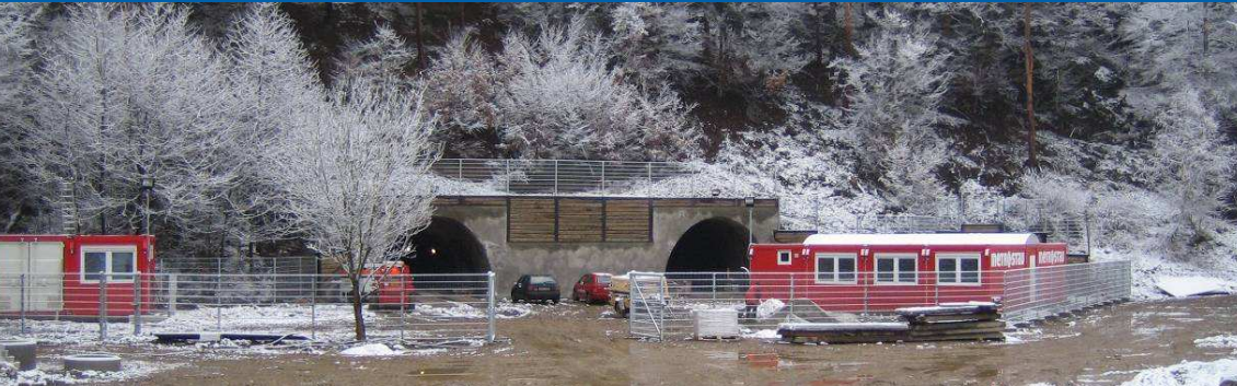
Stav začátkem února 2007 před kolaudací, úpravy štol hotovy. Okolí buňkoviště, které bude sloužit jako provizorní zázemí pro výuku, bude upraveno, až to umožní klimatické podmínky. State of portals in the end of reconstruction in February 2007, underground works completed. Land improvements around site barracks will be finished according to weather conditions.
