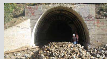
Otevření portálu, odtěžení závážky. Opening of portals, removing of dumpings.
