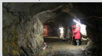
Betonáž podlahy. Concreting of the floor.
