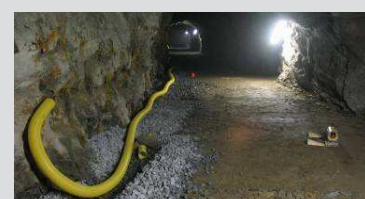
Osazení drenážního potrubí do štrčku, vpravo laser pro vytyčení nivelety podlahy. Drainage system. Laser levelling on the right.
