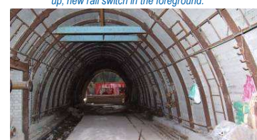
Tunel býv. kompresorovny, předpokládané využití jako zasedací místnost. Former air pump tunnel, probably the future meeting room.
