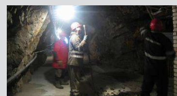
Obtřnění uvolněné horniny. Baring down of unstable rocks.
