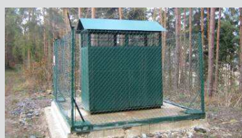
Větrací objekt na ohlubni komínu ŠP-K2. Air cabin on the air shaft mouth.
