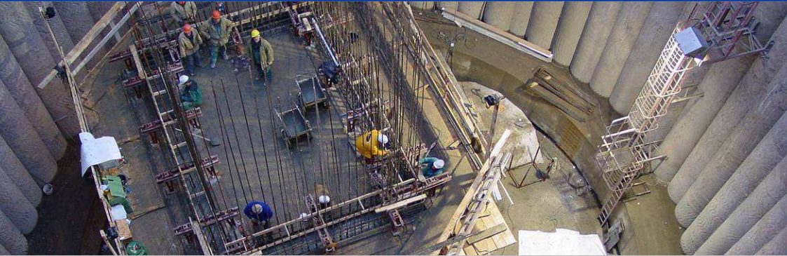
■ Schodišťová šachta únikového východu nad tunelem (výšky 22 m) prováděná technologií taženého bednění
