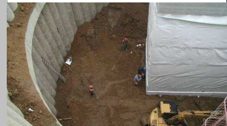
■ Prorážka tunelu do šachty
