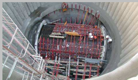
■ Provádění bednění pro sekundární obzdivku
