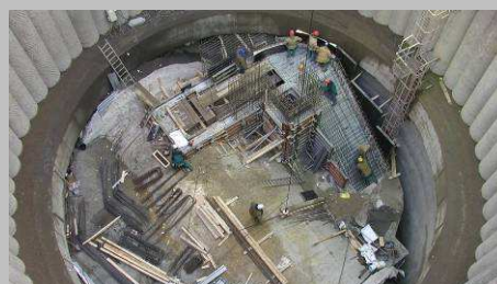
■ Výstavba únikového východu v oblasti tunelu
