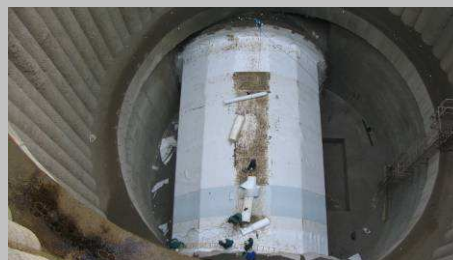
■ Izolace hotového sekundárního ostění
