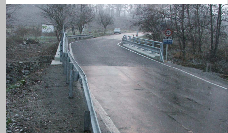
Běleč – most a komunikace po opravě
