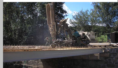
Podchycení opěr mikropilotami
